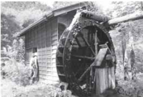
地区で管理・使用される現役の水車
